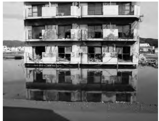
写真4 気仙沼湾に近い地域は地盤沈下をおこし、水たまりが点在している。
