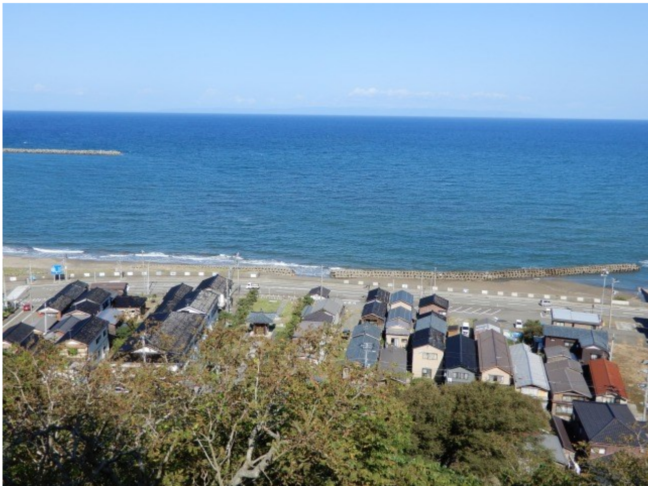
⑨出雲崎の町並みと日本海に浮かぶ佐渡島
